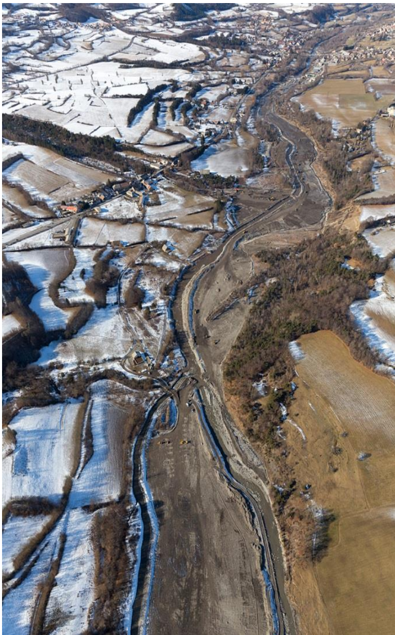
Vue générale du chantier
