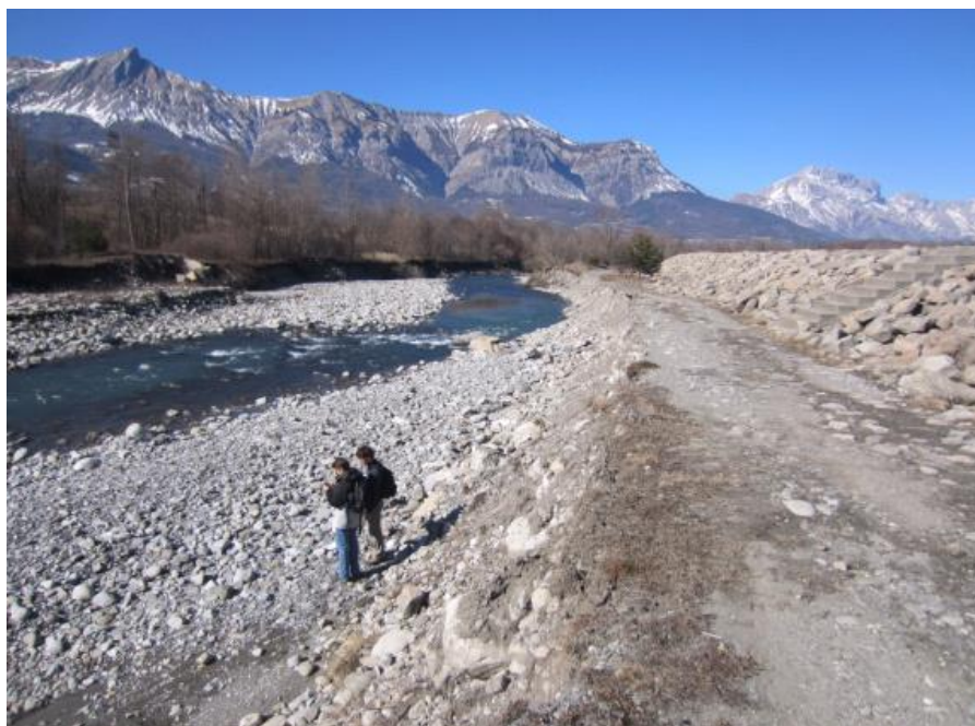
Incision du lit de 3 m au droit de la digue du plan d'eau
