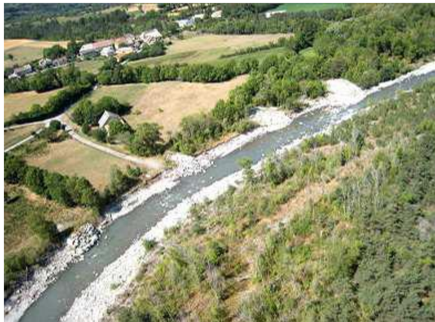
Le Drac en « mauvais état »
